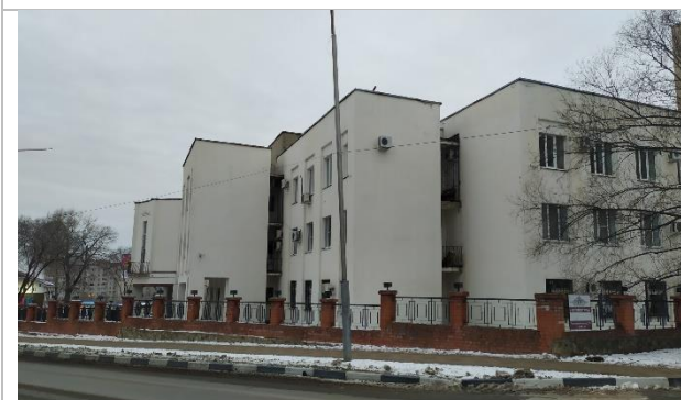
Фото 13. Окружающая застройка, подъездные пути
