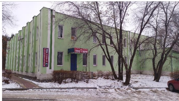
Фотография 3.2. Фасад административного здания
