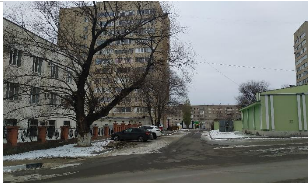
Фото 1. Фасад здания, прилегающая территория
