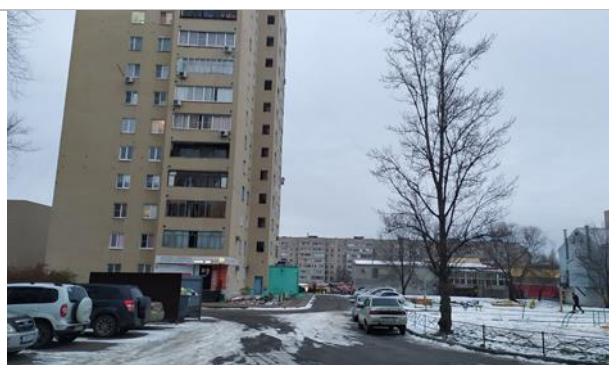
Фото 12. Окружающая застройка, подъездные пути
