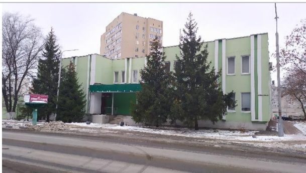
Фотография 3.1. Фасад административного здания
