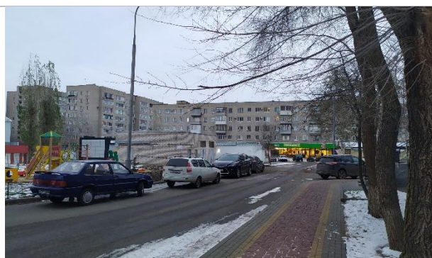
Фото 14. Окружающая застройка, подъездные пути
