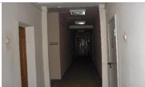
Фото 16. Внутренние помещения по состоянию на 15.02.2019 г.
